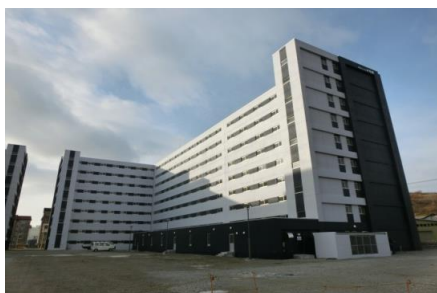
2016年 東町たいわ団地公営住宅 建替電気設備工事
