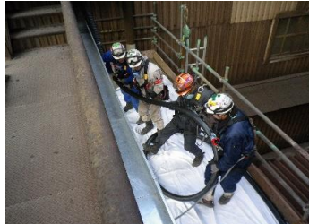
高圧ケーブル延線工事
