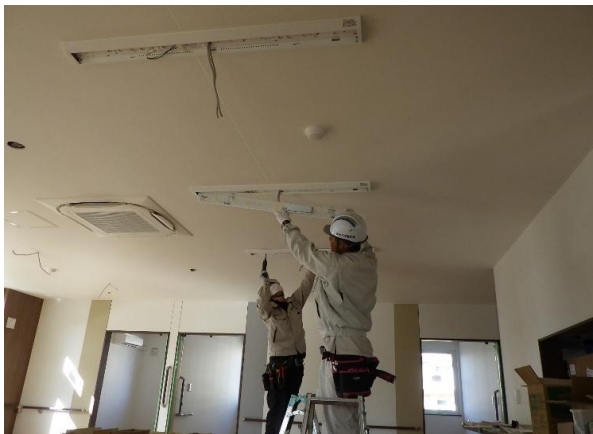
照明器具工事
