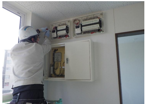
分電盤設置工事
