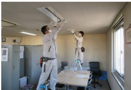
事務所内照明器具LED化工事
