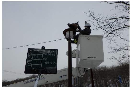
街路灯改修工事
