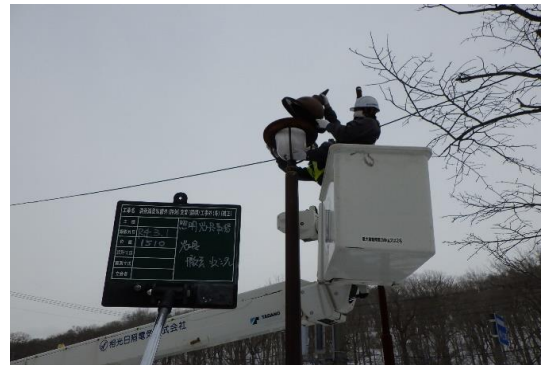
街路灯改修工事
