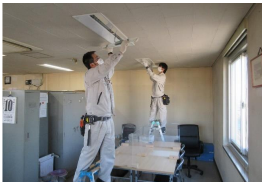
事務所内照明器具LED化工事
