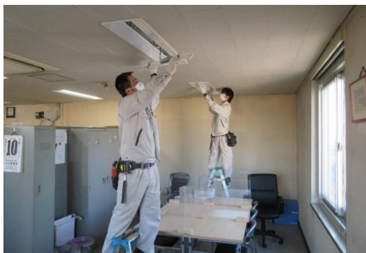
事務所内照明器具LED化工事
