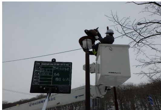
街路灯改修工事
